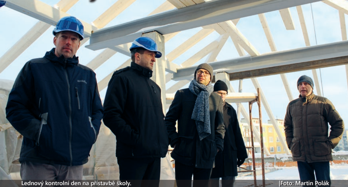
Lednový kontrolní den na přístavbě školy.
