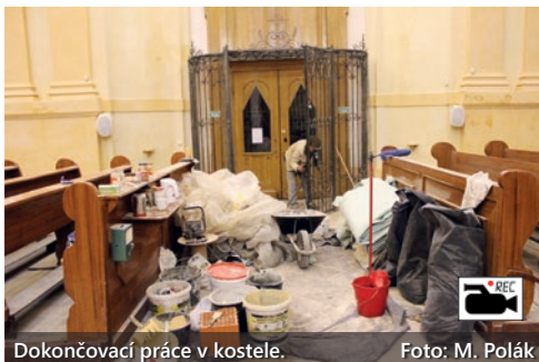
Dokončovací práce v kostele.
