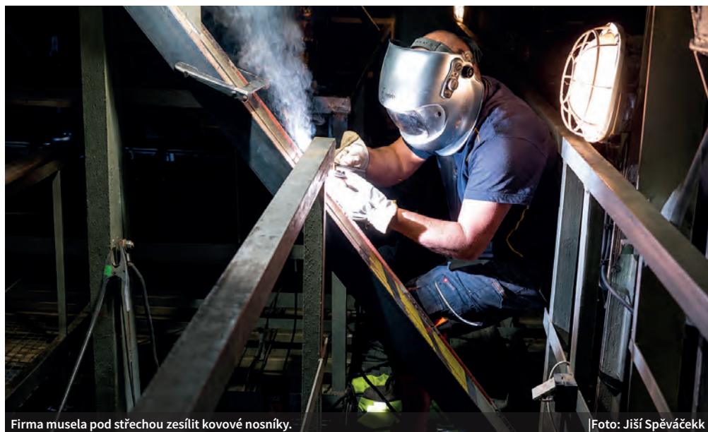
Firma musela pod střechou zesílit kovové nosníky.
