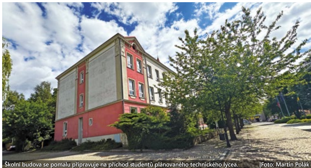
Školní budova se pomalu připravuje na příchod studentů plánovaného technického lycea.
