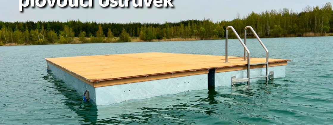
Nový ponton na hladině Bílé vody.
