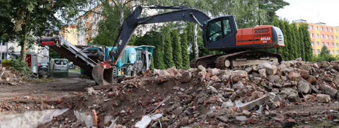
Demolice bývalé mateřské a později základní umělecké školy.
