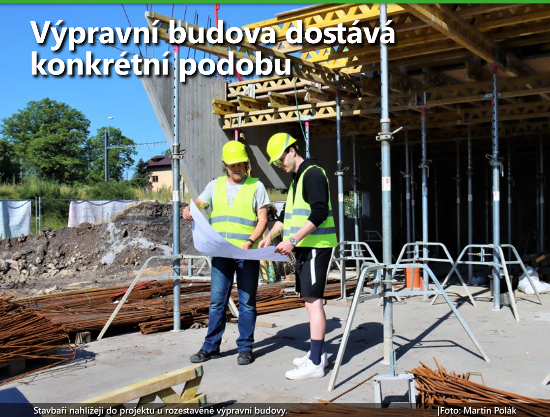
Stavbaři nahlížejí do projektu u rozestavěné výpravní budovy.
