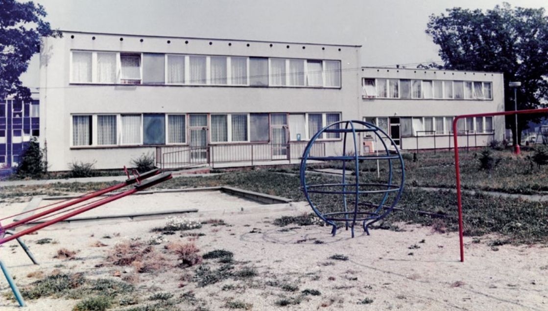
Snímek zachycuje 7. MŠ ve Dvořákově ulici, která fungovala mezi lety 1976–1991. Následně v budově sídlili dětský lékář, výroba knedlíků. Dnes je budova přestavována na novou knihovnu. [Foto na dvoustraně: archiv M. Bělohávkva
