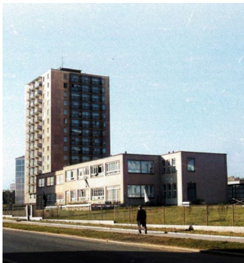
Areál 5. MŠ ve Školní ulici krátce po svém dokončení.
