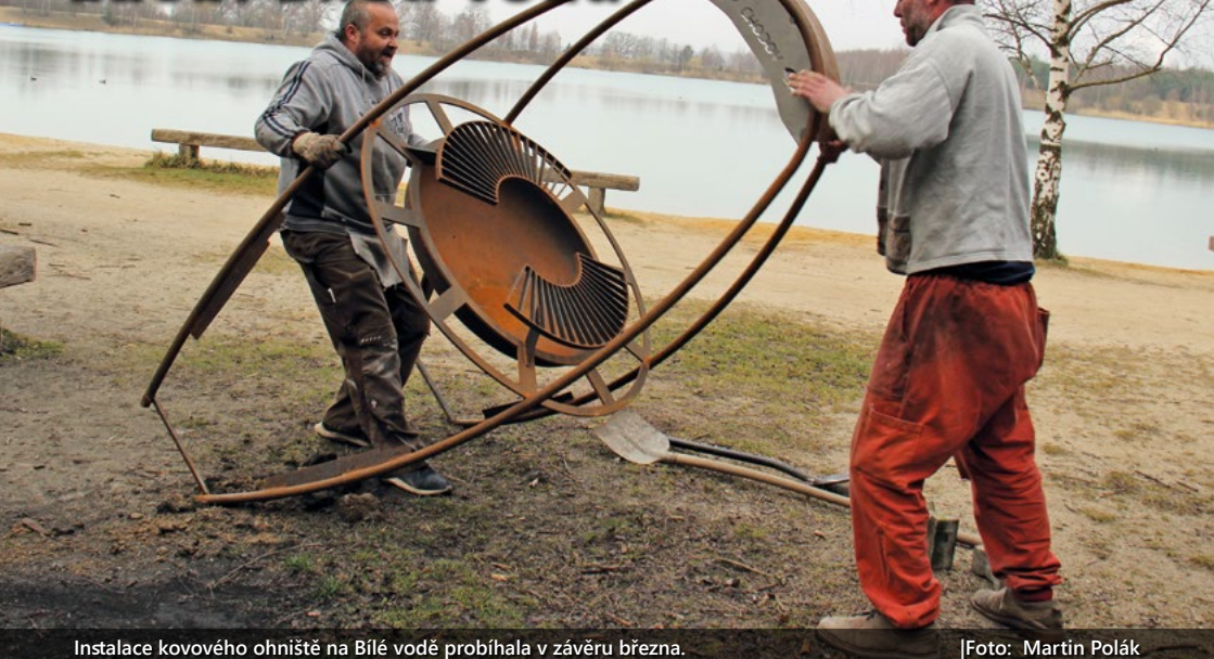
Instalace kovového ohniště na Bílé vodě probíhala v závěru března.
