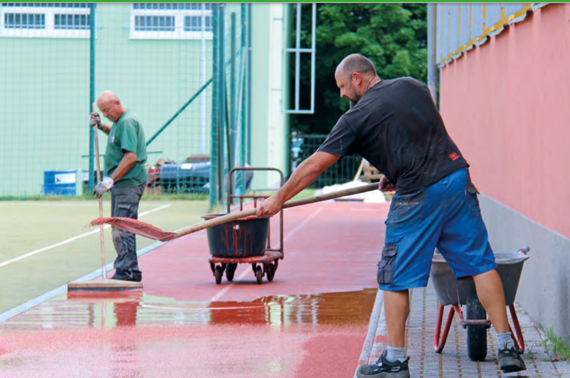
Kromě běžné údržby prováděla v závěru prázdnin ZŠ Školní také práce ve venkovním prostředí, a to na přilehlém školním hřišti. Nový povrch tak dostaly atletická dráha o délce 65 metrů a třicetimetrový rozběhový pruh před doskočištěm.
