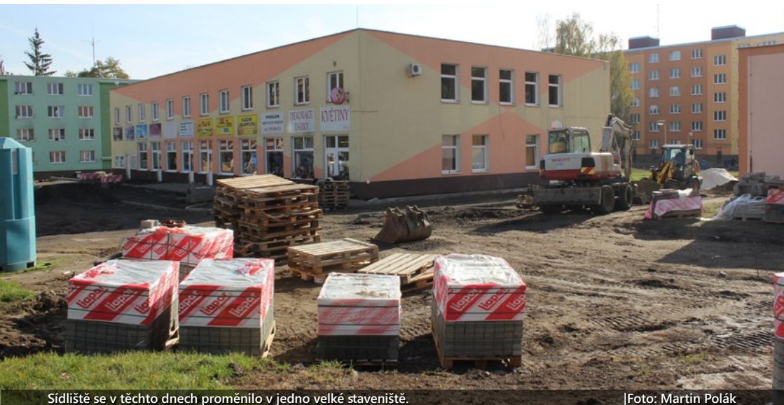
Sídliště se v těchto dnech proměnilo v jedno velké staveniště.
