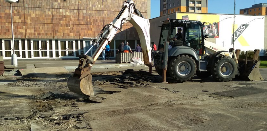
Práce na opravě poškozeného povrchu před KASSem.
