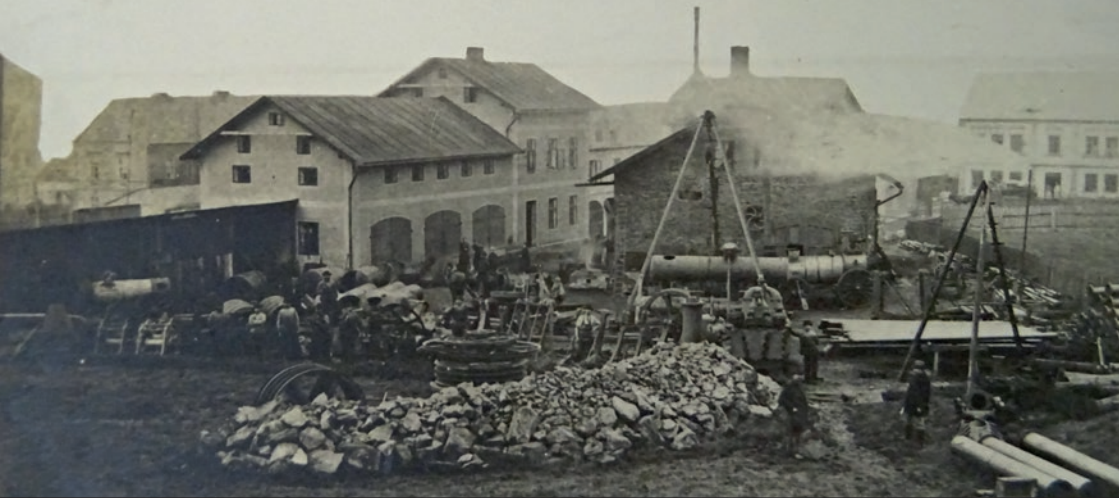
Areál Gaschových strojíren nedlouho po svém vzniku na snímku z roku 1890.
