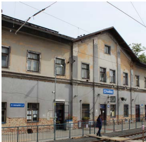
Starou nádražní budovu čeká oprava. [Foto: M. Polák]
