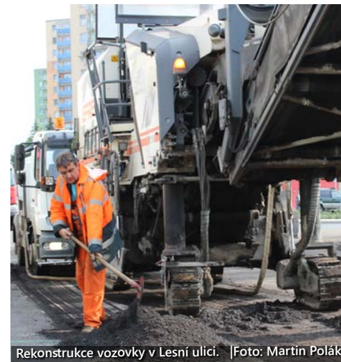
Rekonstrukce vozovky v Lesní ulici. [Foto: Martin Polák]
